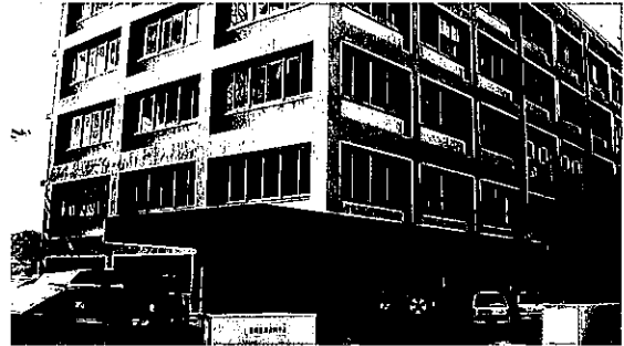
長崎入管（港湾合同庁舎内）
